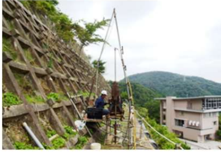
ボーリング調査
